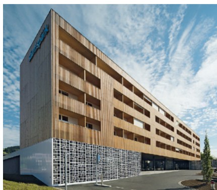
Die Erweiterung des Hotels Säntispark wurde in Holzbauweise in acht Monaten realisiert
