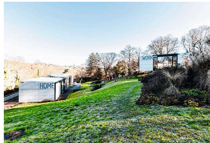
Das Zukunftshaus in Wien-Hernals besteht aus zwei Gebäuden
