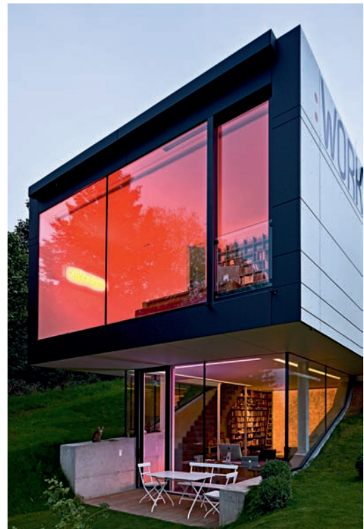
Die Lichtfarbe des „Work-Hub“ signalisiert ... | The light colour signalises ...
